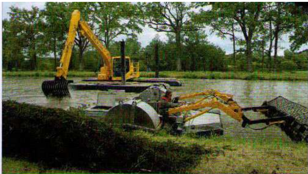
Le chantier d'entretien du canal de Nantes à Brest est un terrain d'expérimentation idéal pour la pelle Big Float. Au premier plan, un dispositif de ramassage des végétaux coupés.
