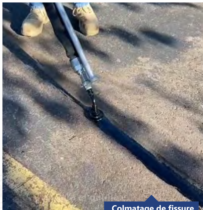
Colmatage de fissure
