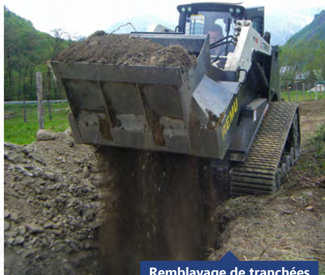
Remblayage de tranchées
