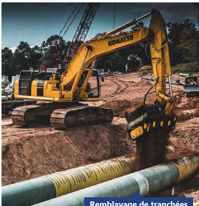
Remblayage de tranchées
