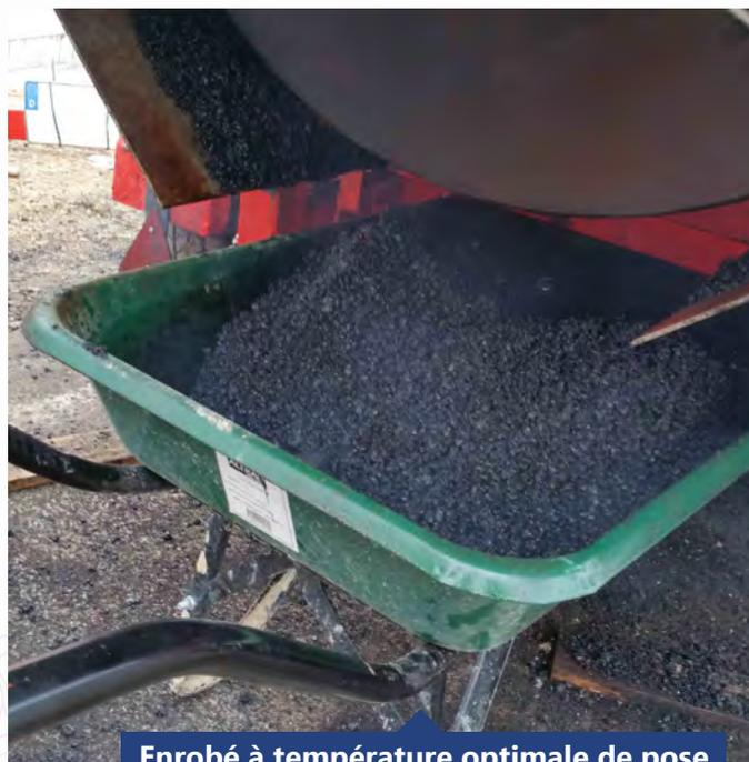
Enrobé à température optimale de pose
